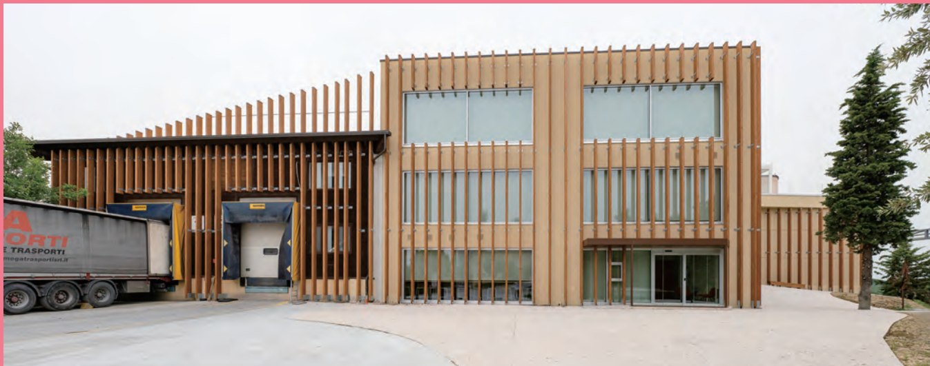
改装工事を終えた社屋外観
